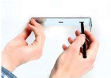
Je nach Anzahl der Halteschienen und Abdeckungen sind diese entsprechend der späteren Befestigung über dem Kochfeld zu vermitteln. Bei zwei Abdeckungen sollten diese vertikal über den Aufhängepunkten der Haube positioniert sein. Haben Sie die Bohrlöcher für die Halteschrauben eingebohrt, können Sie nun die Halteschienen an der Decke verschrauben.
