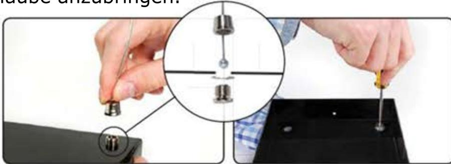
An der Haube befinden sich Halteklammern die durch Eindrücken des oberen Teils geöffnet und dadurch die Seillänge entsprechend der späteren Höhe der Abhängung eingestellt werden können. Alle Seile sind dabei so einzustellen, dass die Haube nach Verschraubung der Abdeckung an der Decke horizontal gerade hängt.
