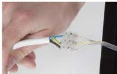
Achten Sie unbedingt darauf, dass während der Installation das bauseitige Anschlusskabel stromlos ist und die Anschlussklemmen fest verschraubt werden.
