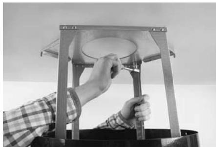
Sitzt die Haube nun fest an der Halterung, kann der Stromanschluss als auch der Abluftanschluss (sofern vorgesehen) vorgenommen werden und danach die obere Abdeckung auf der Halterung nach oben gezogen und seitlich an den dafür vorgesehenen Halteklammern verschraubt werden.
